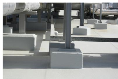
**Recomendações Sika para coberturas congestionadas e de acesso difícil:** SikaRoof® i-Cure membrana líquida, que também pode ser utilizado para detalhes seguros nos sistemas de membrana única da Sika.
