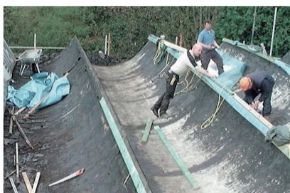
**Recomendações Sika para a reabilitação de coberturas betuminosas:** Sika Sarnafil® TG 76 Felt FPO sistema de impermeabilização de coberturas aderido, ou SikaRoof® i-Cure membrana líquida.
