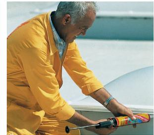
**Nos sistemas de Coberturas planas** são necessários selantes de junta elásticos para selar as diferentes juntas, como clarabóia ou qualquer outra penetração na cobertura e entre as chapas metálicas laminadas. Os principais requisitos para os selantes nessas aplicações são:
