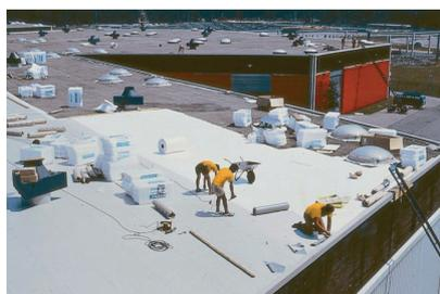
**Recomendações Sika para a reabilitação de coberturas poliméricas:** Sika Sarnafil® TS 77 FPO sistema de impermeabilização de coberturas fixado mecanicamente, ou SikaRoof® i-Cure sistema de membrana líquida.
